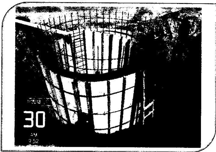
FOTO 18: Se realiza el encofrado del muro armado circular del Tanque Depósito de Efluentes e=20cm , Acero en losa y muro \varnothing 1/2 @ 0.25m ambos sentidos.
